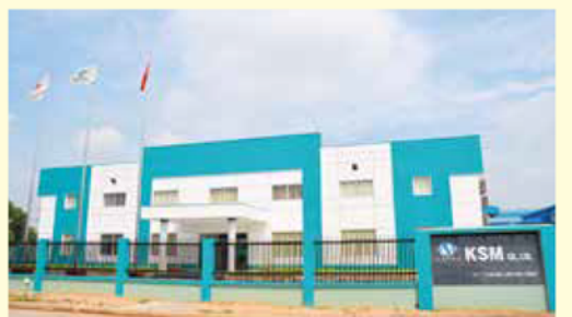
現在のベトナムロンタン工場(3面より)
