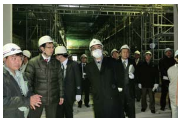
12月10日府笠原商工部長らと工事現場を視察
