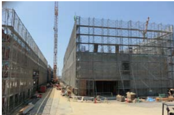
8月現在、工事が急ピッチで進行
