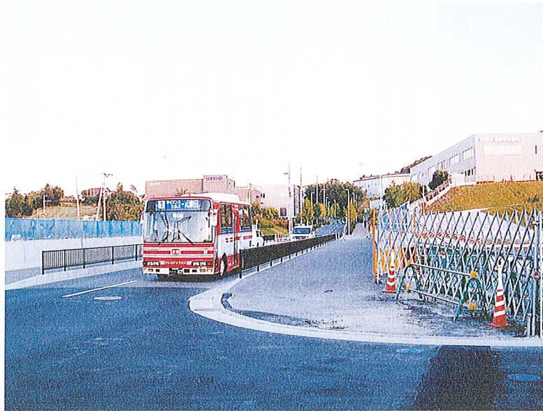
津田サイエンスヒルズ連絡橋に京阪バス・大型車などの通行が多い。
